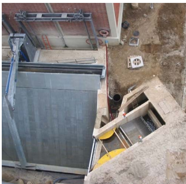
Abb. 9: Oberflächennaher Bypass für Lachssmolts (WKA Roeamond, NL, Rur)
