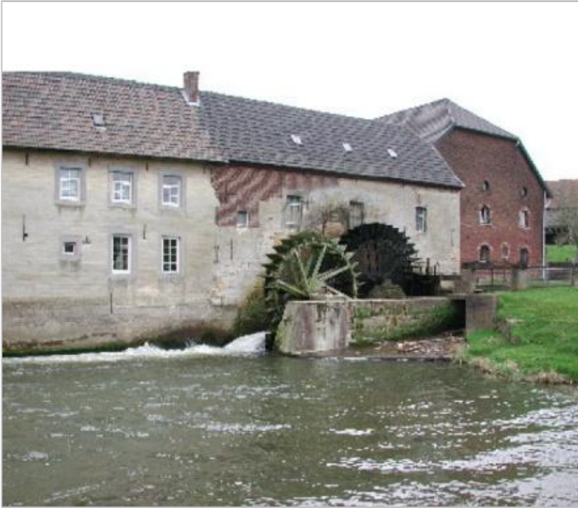
Abb. 2 Wasserräder der Molen Otten von Unterwasser (R. Gubbels, April 2007)
