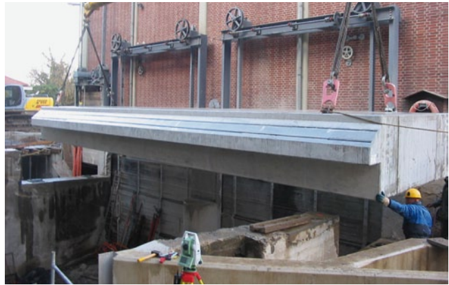
Bild 3: Einheben der Fertigbeton-Brücke als obere Anlage des Rechens und zur Aufstellung des Rechenreinigers
