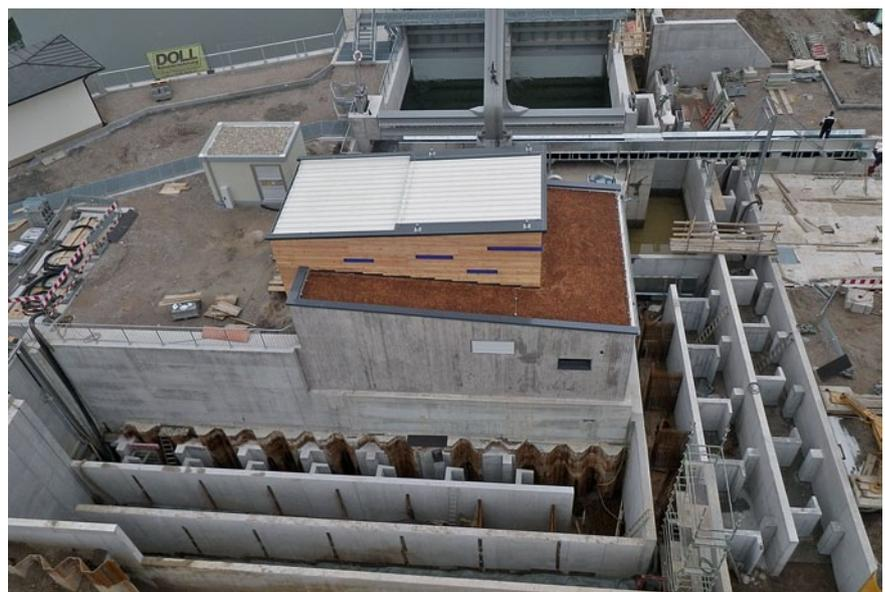
Bild 3: Baugrube im Frühjahr 2013: Im Vordergrund ist der Vertical-Slot-Pass sichtbar, der das Krafthaus zweiseitig umschließt, oberhalb des Krafthauses ist der Zulaufkanal mit der Rechenreinigungsmaschine sichtbar
