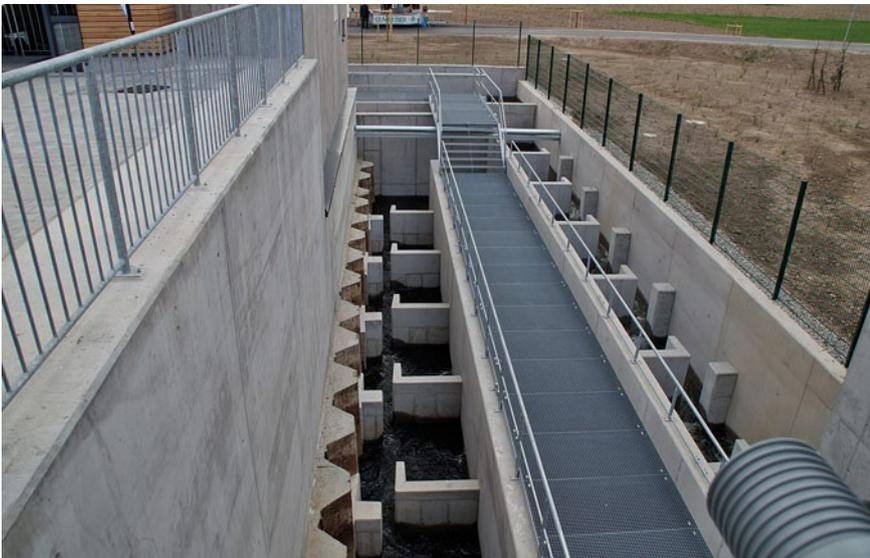
**Bild 5:** Unterer Abschnitt der Fischaufstiegsanlage
