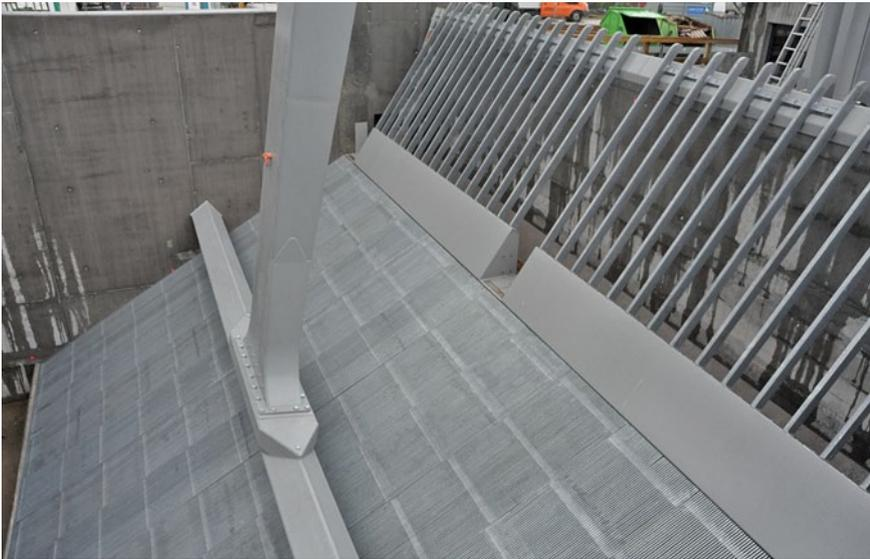
**Bild 4:** 10-mm-Feinrechen mit der Harke der Rechenreinigungsmaschine und den oberflächennahen Bypassöffnungen
