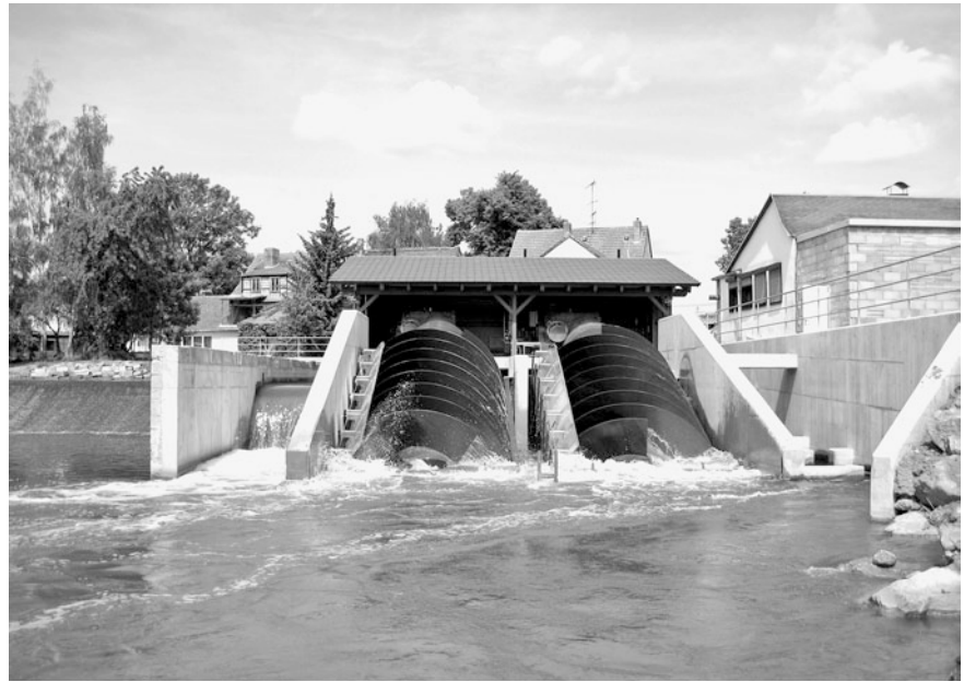
Bild 5: Wasserkraftschnecken am Standort Artern, Einstieg Schlitzpass (FAA) rechts
