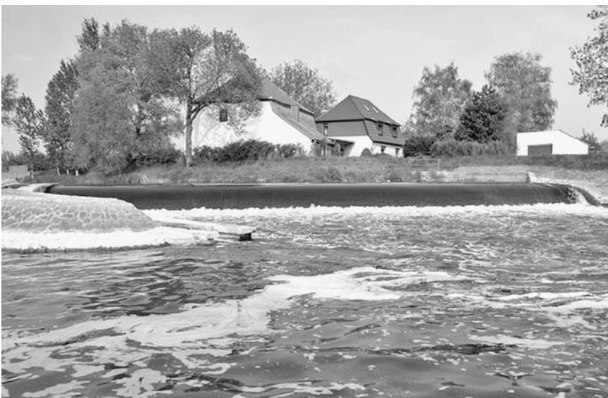
Bild 7: Bisher ungenutzter Standort mit technischem Potenzial zur Wasserkraftnutzung
