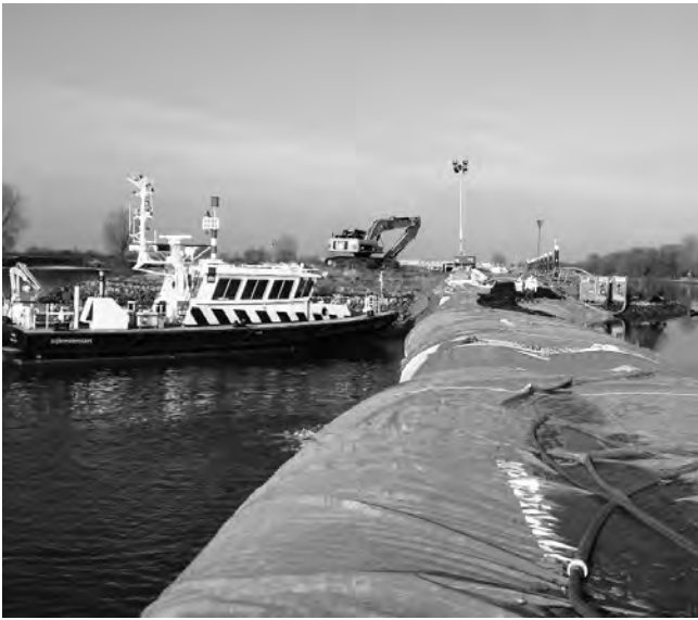
Bild 3: Einbau des Mobildeichs MD350-2 im 0,5 m tiefen Wasser (Quelle: Mobildeich GmbH)
