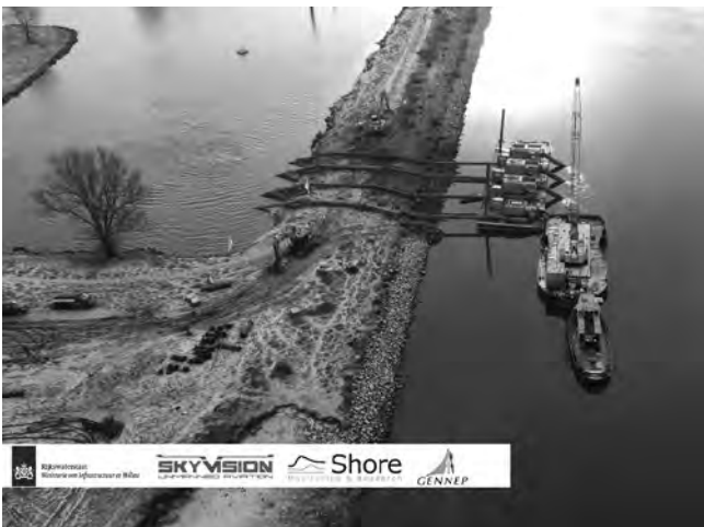
Bild 5: Pumpenanlage am Hafenbecken von Gennep (Quelle: Rijkswaterstaat)
