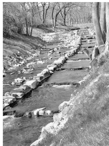
Bild 2: Ehemaliger Wehrstandort nach Umbau in ein geteiltes Raugerinne mit Beckenstruktur
