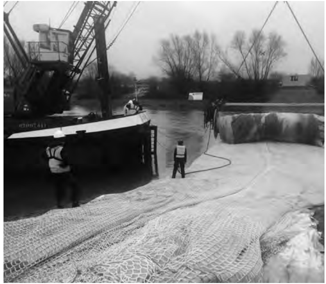
Bild 4: Mobiler Deich bei eingestautem Hafenbecken (rechts) (Quelle: Rijkswaterstaat)
